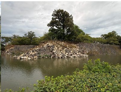
八代城跡地(石垣崩落)
