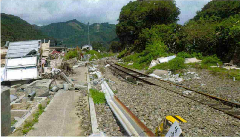
JR肥薩線の 線路が被害を 受けている状況 と被災家屋
