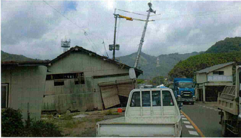
令和2年 8月28日 大雨豪雨災害 現場 球磨郡球磨村 茶屋地区被害 状況 家屋・電柱等が 水没してしまった 地区の状況
