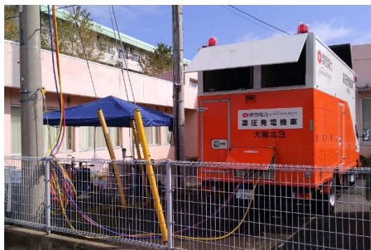
送電する発電機車の傍らで監視業務を行う。暑さ対策のテントを設営。青、黄、赤のケーブルを柱上の開閉器負荷側へ接続し送電を行っている。
