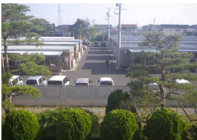
2014 年 10 月 屋下がりの仮設住宅
